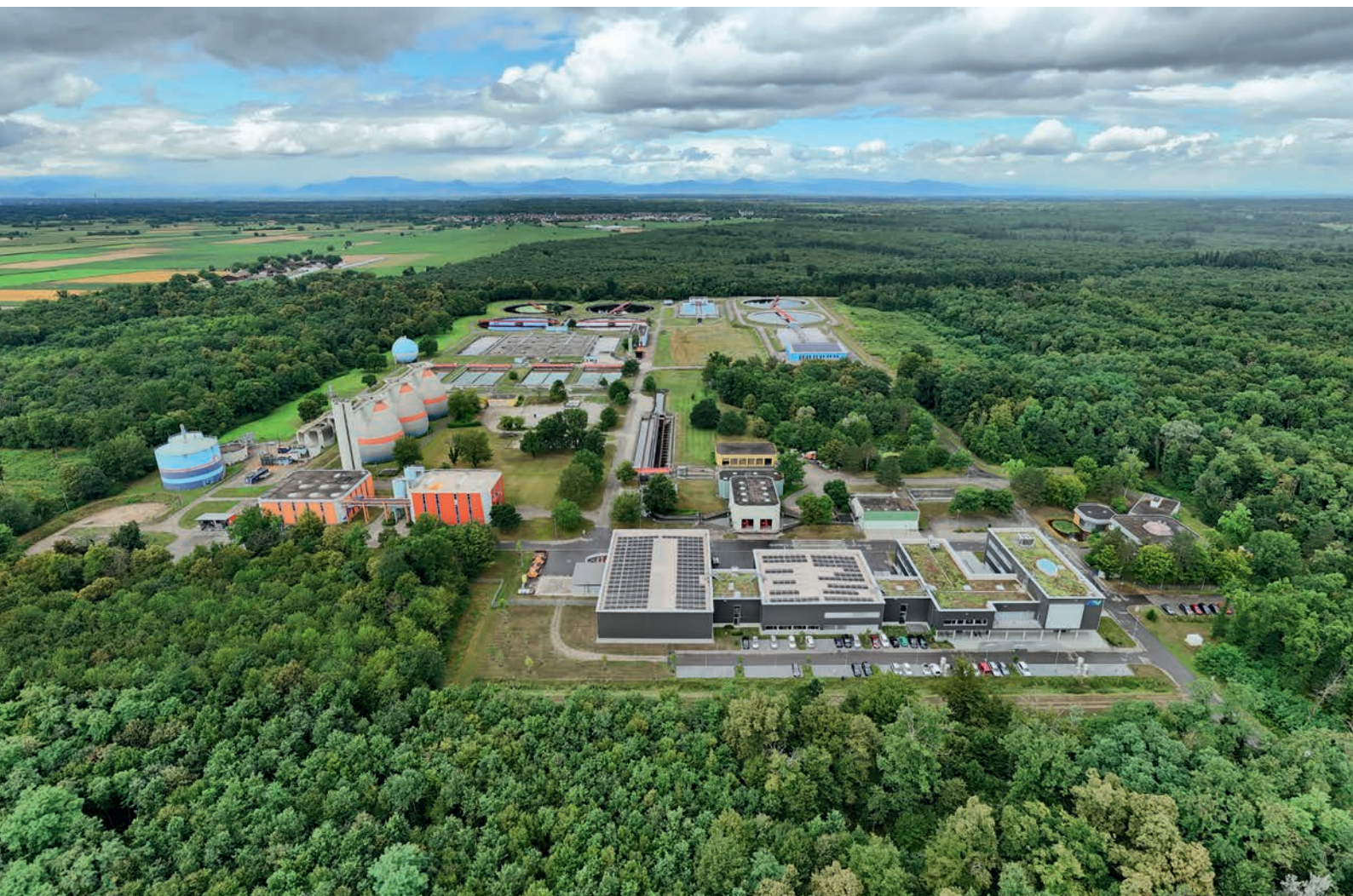
Luftbild Klärwerk Forchheim
