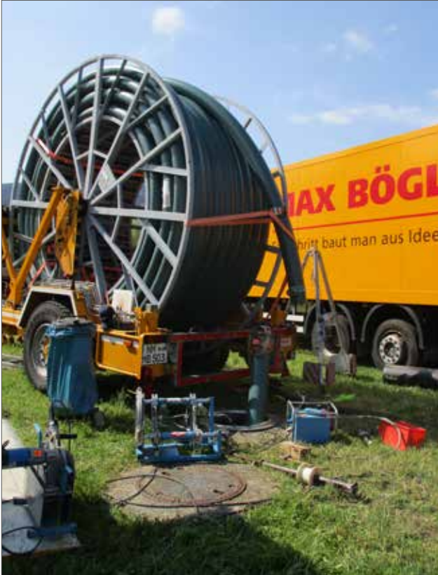
PE-Schlauchliner auf Transporttrommel
