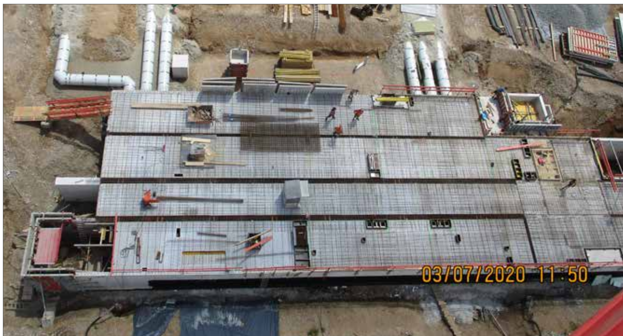
Luftbild Baustelle Betriebsgebäude
