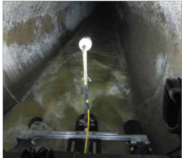
Optische Kontrolle eines Verbandsabschnitts
